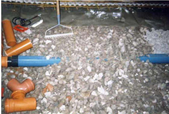
Abb. 3: Verlegung von Drainagerohren in einer Schüttung aus 25 cm Schotter
