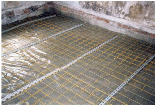
Abb. 4: Radondichte Folie mit aufgebrachtter Armierung
